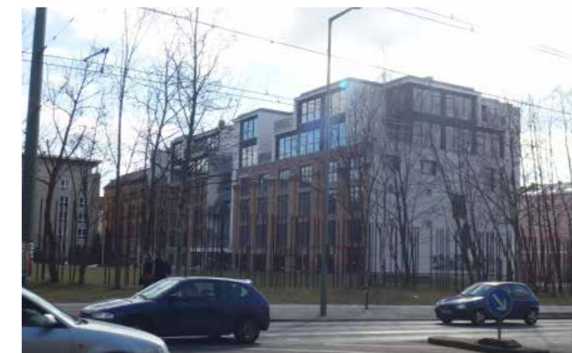
Wohnungsneubau in der Bernauer Straße, Berlin
