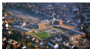
04 Schrägaufnahme, Fertigstellung Herbst 2011
