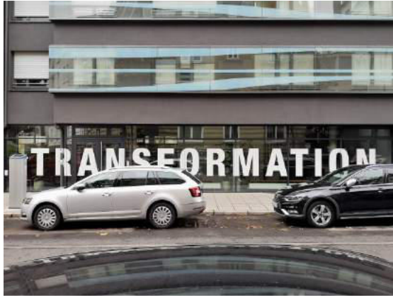
Transformation Innenstadt: Quartier Tübinger Straße-Marienplatz, Stuttgart-Süd (Foto: F. Gwildis)
