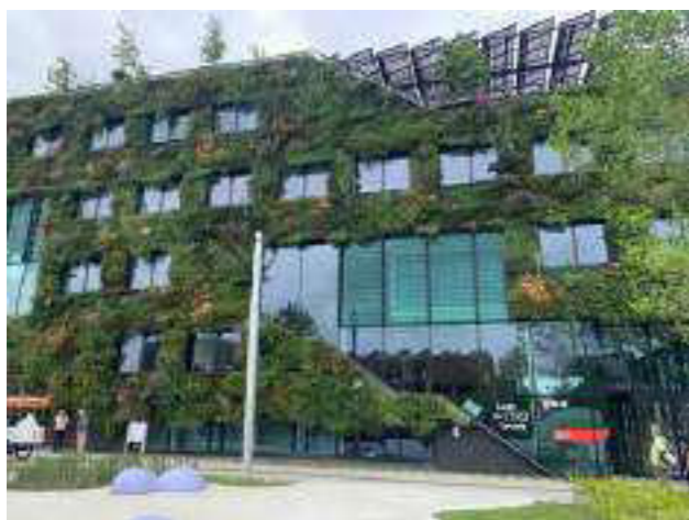
Abb. 4: Modernes Dienstleistungsgebäude 2022 auf der Floriade in Almere. Fassaden- und Dachbegrünung kombiniert mit Sonnenkollektoren auf dem Dach tragen zur energetischen Anpassung an den Klimawandel bei (Foto: Rüdiger Brand)
