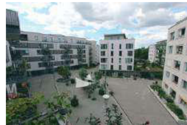
Uferwerk, Werder (oben) und Möckernkiez, Berlin (unten) © Weeber+Partner
